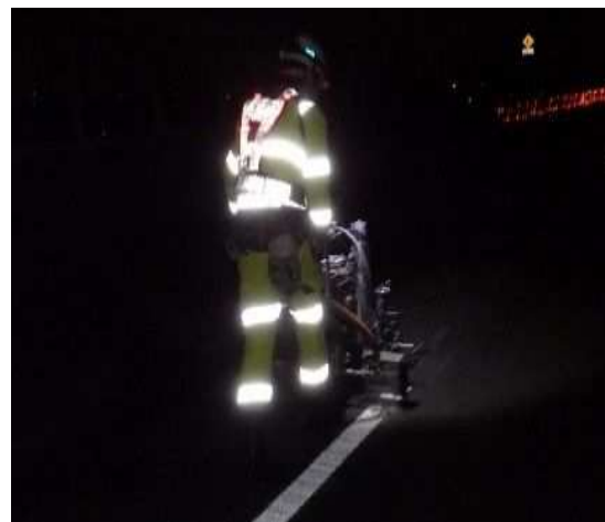
通行止めによる維持工事
